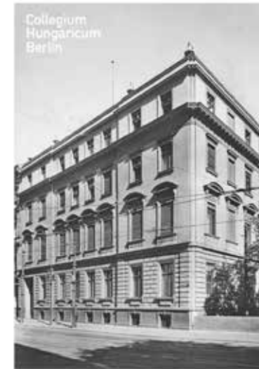
Das Gebäude des Collegium Hungaricum in den 1920er Jahren und der 2007 am alten Standort eröffnete Neubau
